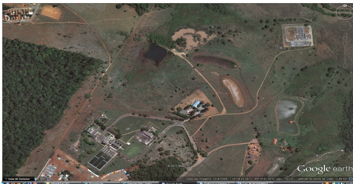
Figura 13: Foto - Captação de água Bruta – Sistema Meia Ponte – Goiânia/GO
