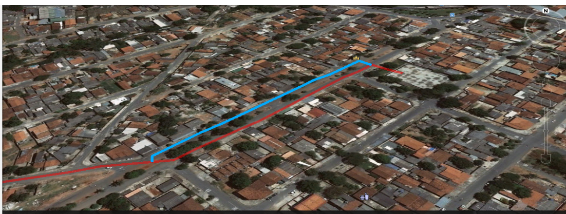
Figura 14: Foto, Tomada de água do sistema SENAC - Palmito
