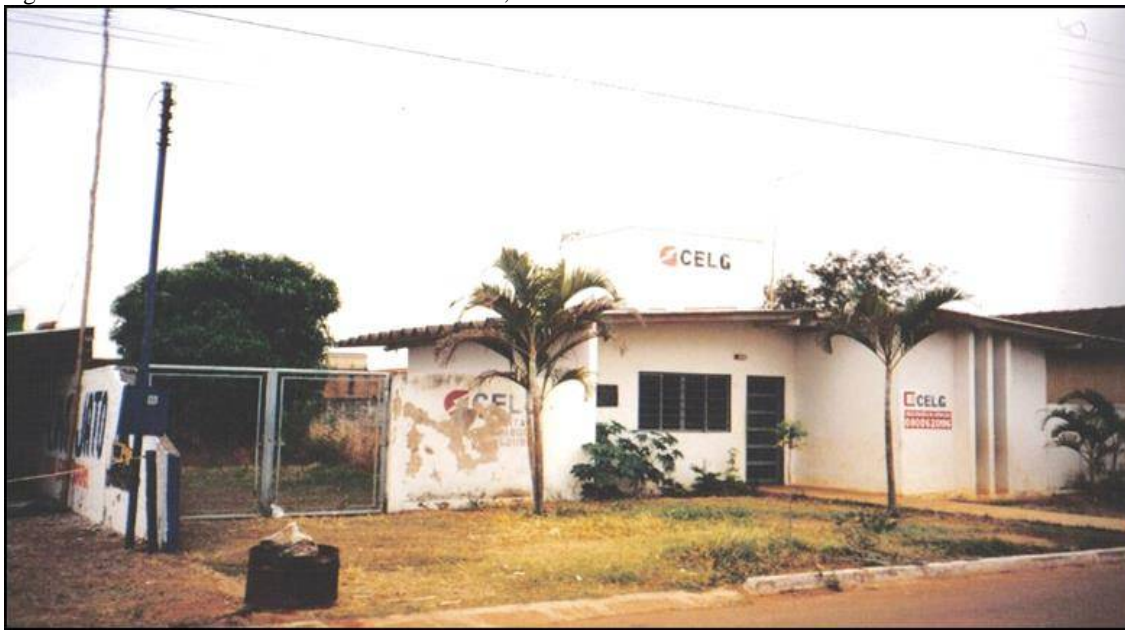
Figura 20 – Centrais e Elétricas de Goiás – CELG, em foto de 2000
