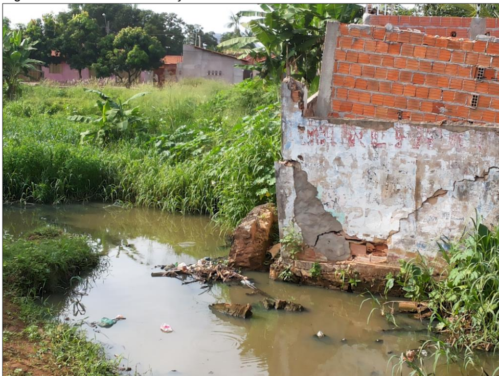
Figura 21 – Reforma/construção no leito do riacho
