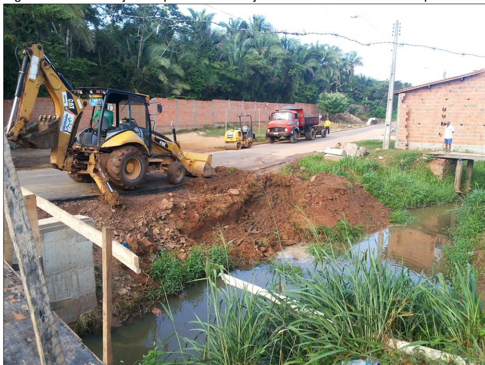
Figura 24 – Construção de ponte e contenção de encosta no Riacho Capivara
