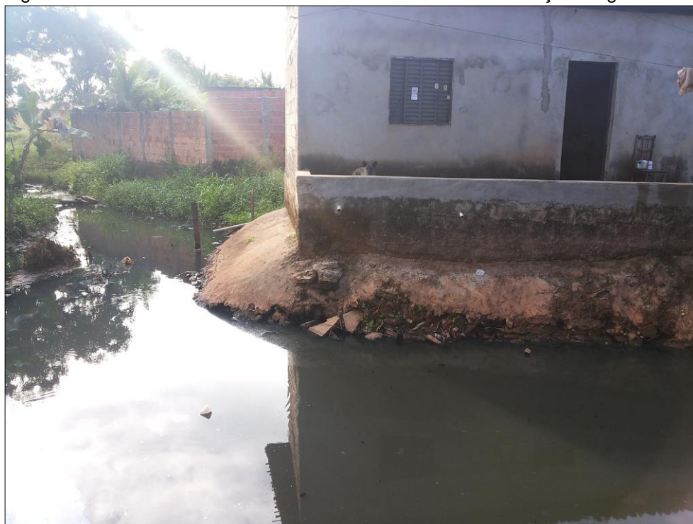
Figura 23 – Desvio no curso do riacho em detrimento da construção irregular
