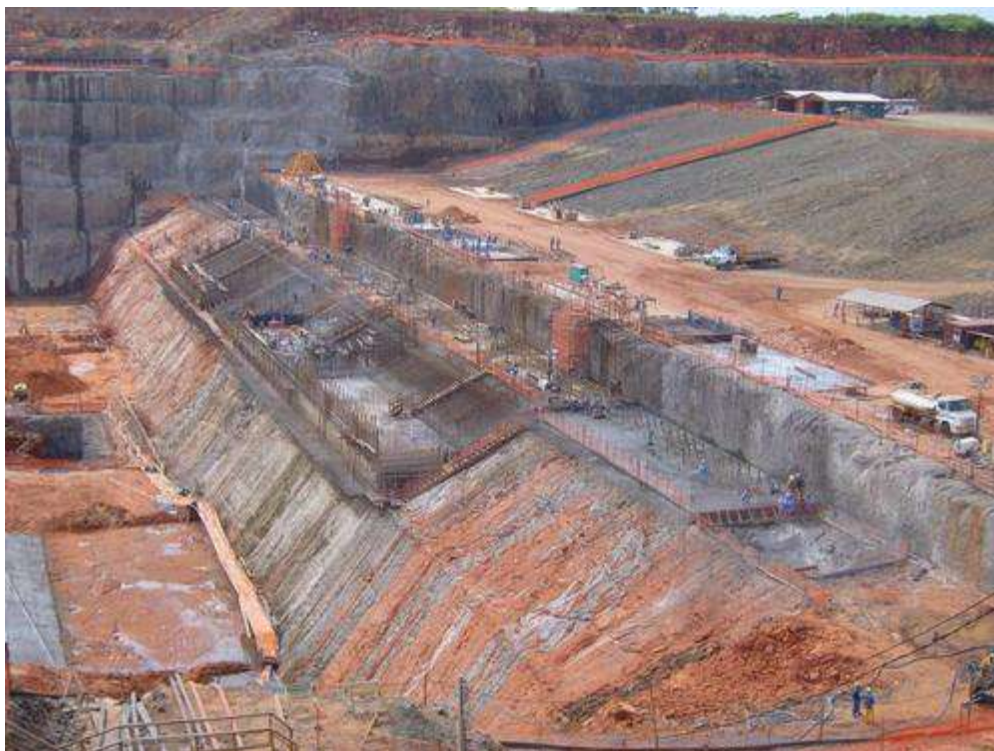
Figura 3: Construção da hidroelétrica de Estreito (a) e estágio dos trabalhos de construção, no Estado do Maranhão (b). Fonte: Imagens@DigitalGlobeCities/Spot
