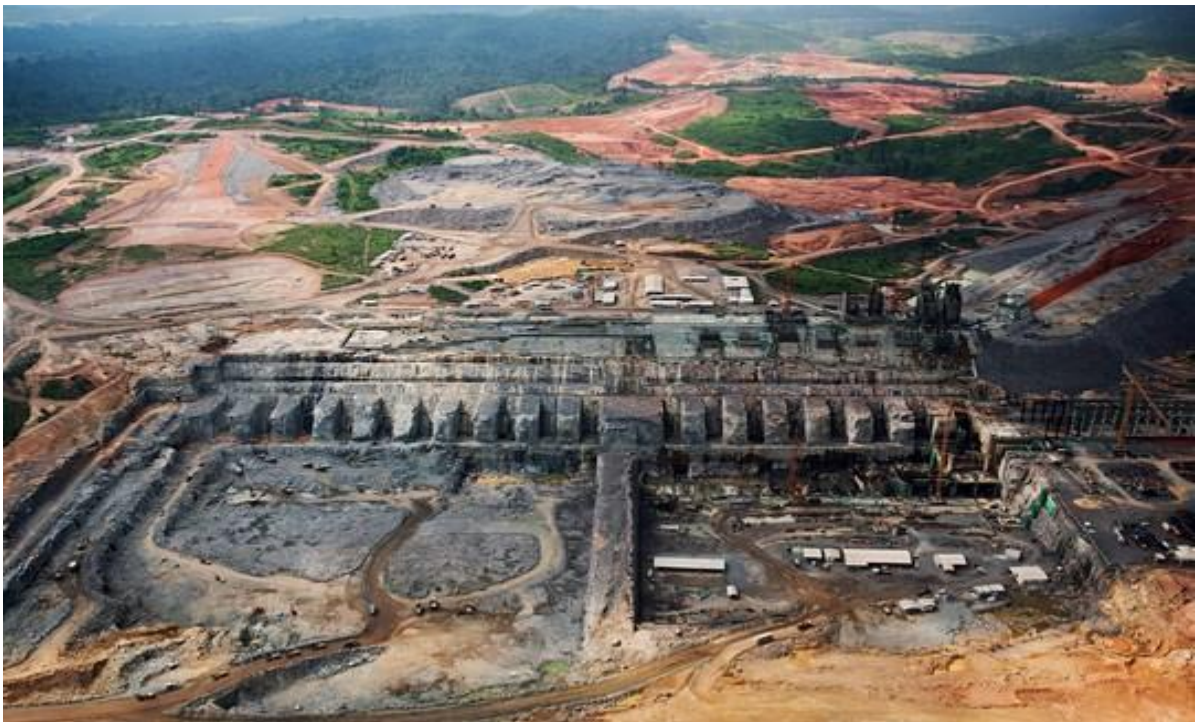
Figura 4 - Canteiro de Obra da Usina Hidrelétrica Belo Monte
