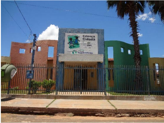
Figura 13 - Fachada do CMEI Valéria Jaime P. Perillo
