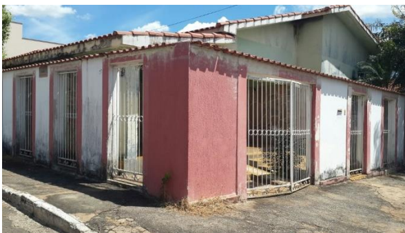
Figura 7: Fachada do CMEI Shekiná
