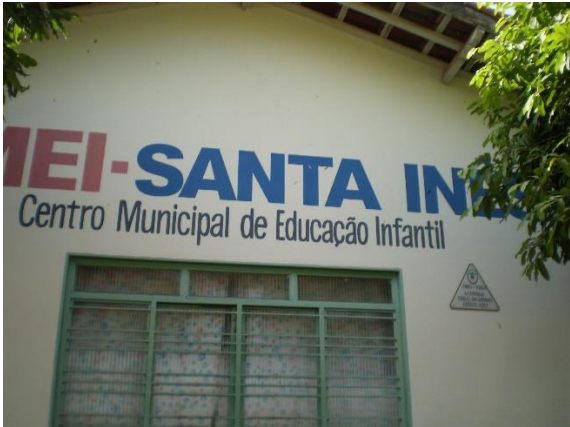
Figura 5: Fachada do CMEI Santa Inês
