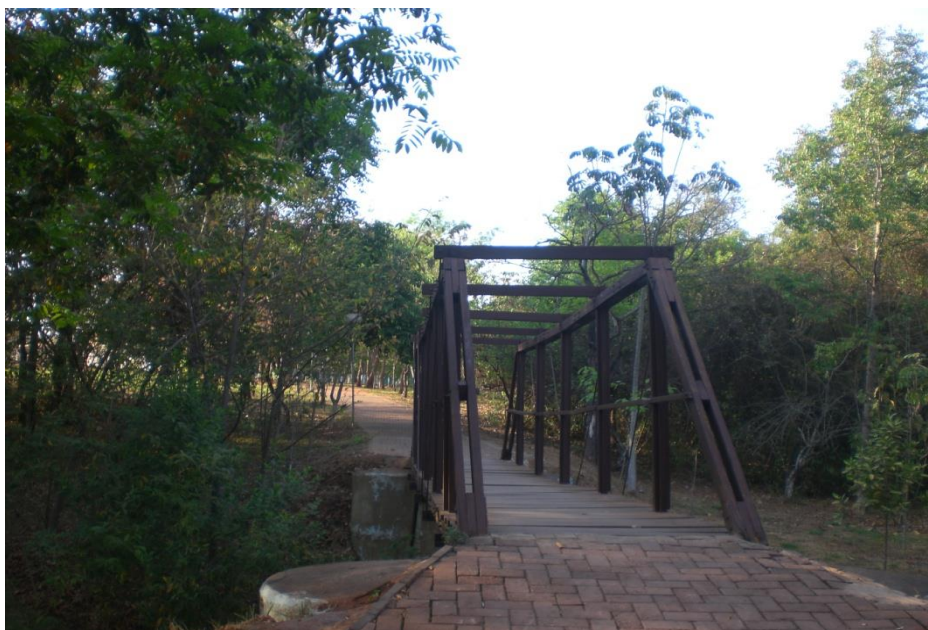
Figura 37: Ponte interligando as duas áreas Fonte: Foto do autor da dissertação
