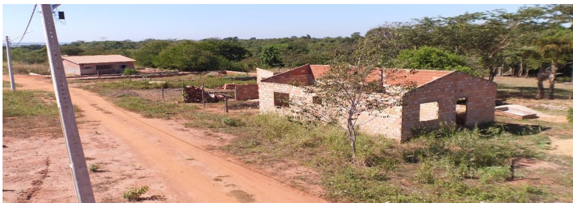
Figura 19 – Nova Era, em 30/05/2020 – construções abandonadas
