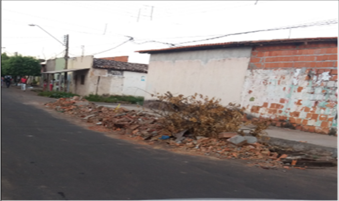
Foto 01: Acomodação inadequada de RCC em via pública no Bairro Bacuri /Imperatriz/ MA.
