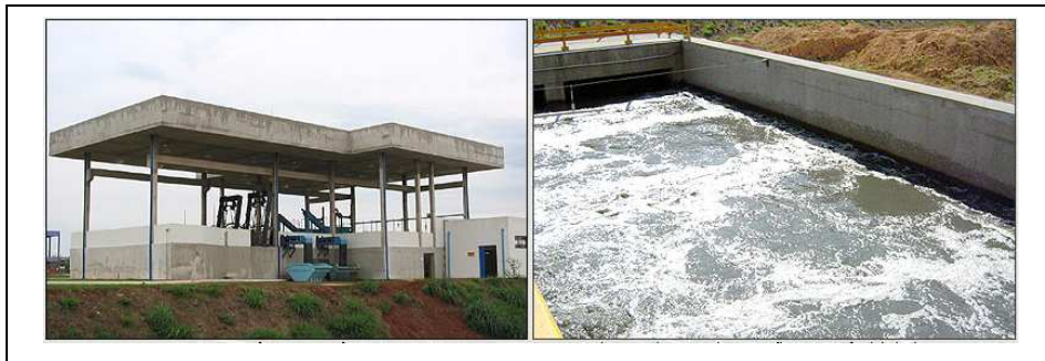
Figura 11 – ETE Goiânia: caixa desarenadora Fonte: SANEAGO (2010a.)
