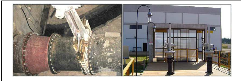
Figura 8 – ETE Goiânia: estação elevatória de esgoto bruto/chegada esgoto Fonte: SANEAGO (2010a.)
