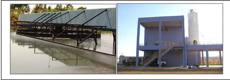
Figura 15 – ETE Goiânia: braços raspadores e unidade de tratamento do lodo Fonte: SANEAGO (2010a.)
