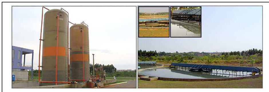
Figura 14 – ETE Goiânia: reservatórios de produtos químicos e decantadores circulares Fonte: SANEAGO (2010a.)
