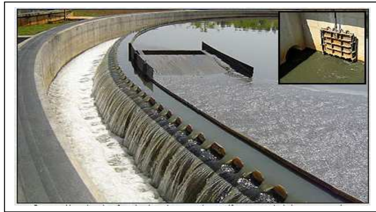
Figura 17– ETE Goiânia: efluente clarificado Fonte: SANEAGO (2010a.)
