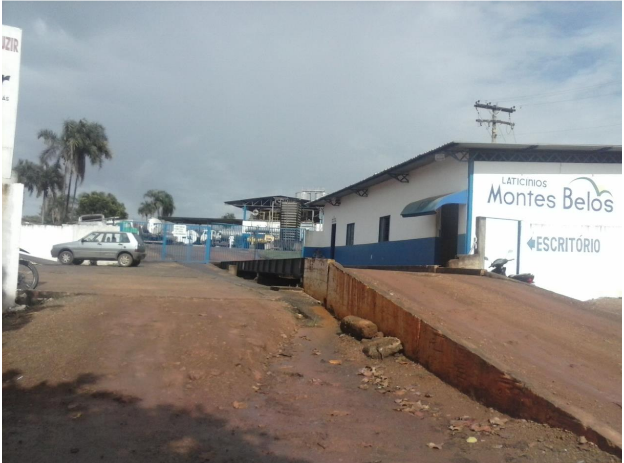
Figura 08: Entrada principal do Laticínios Montes Belos
