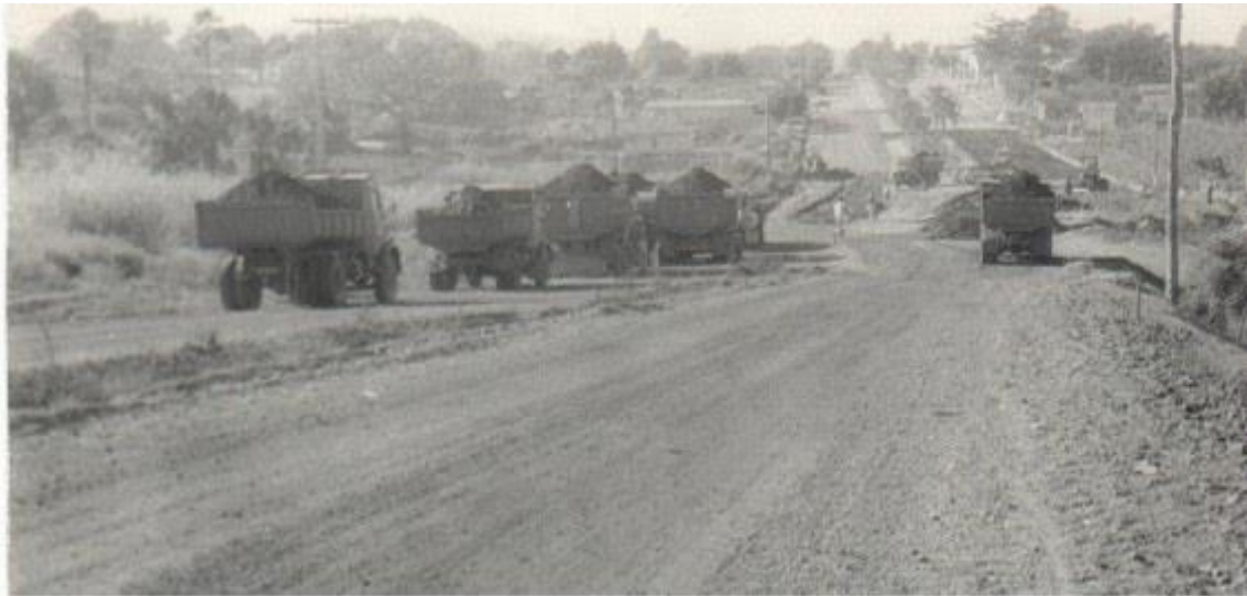
Figura 2 – Foto da construção da Av. Hermógenes Coelho em 1955.
