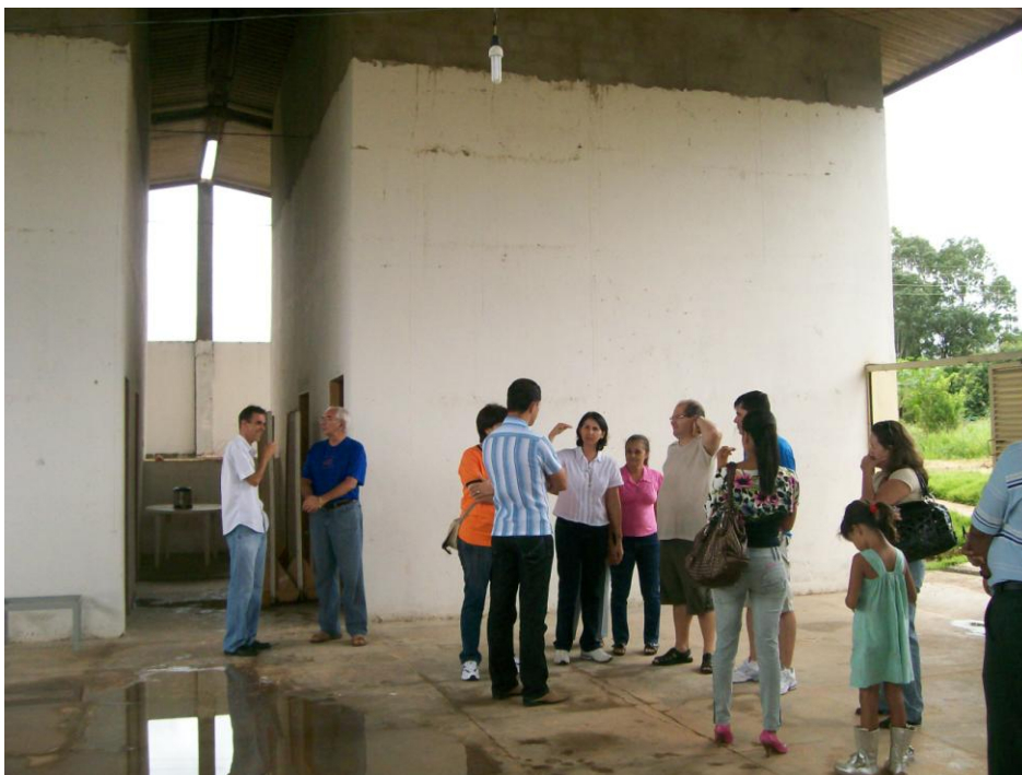
Figura 03 – Galpão que está sendo construído com a doação do Itaú e de doadores.
