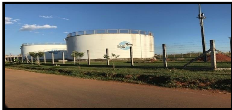
Figura 23 – Sistema de Abastecimento de Água Jardins do Cerrado
