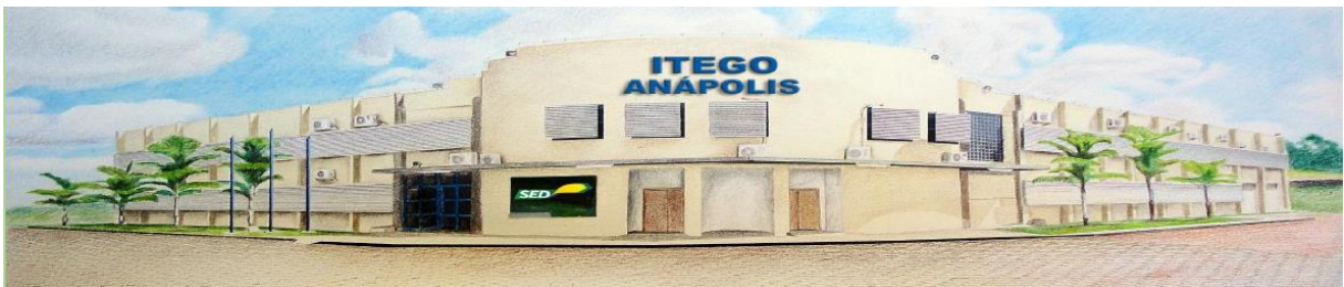
Figura 3: Fachada do prédio do ITEGO Anápolis
