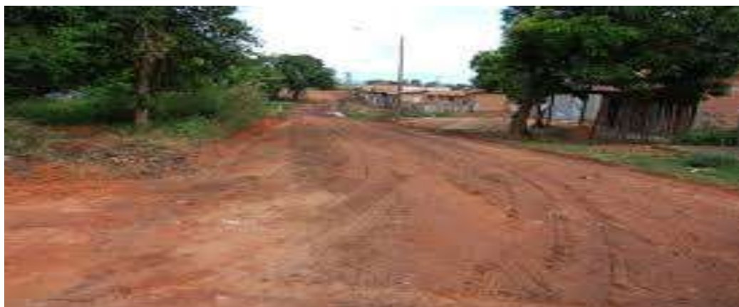
Foto 11 – Rua não pavimentada do Bairro Parque das Palmeiras
