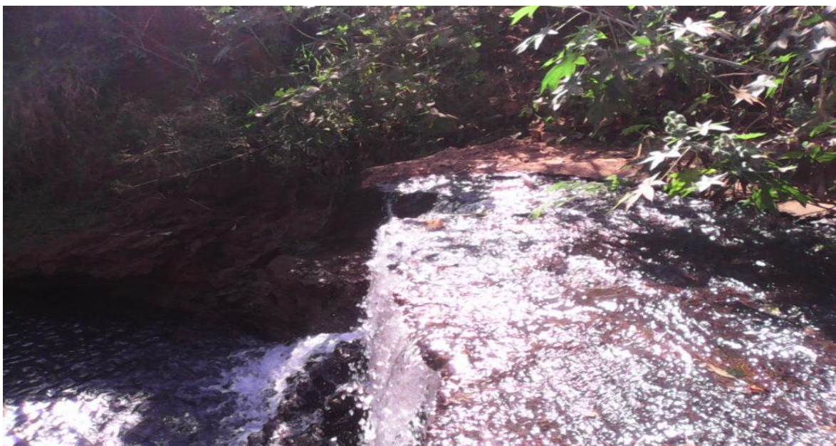
Figura 35 – Estrutura em concreto edificada no leito do córrego Veredinha
