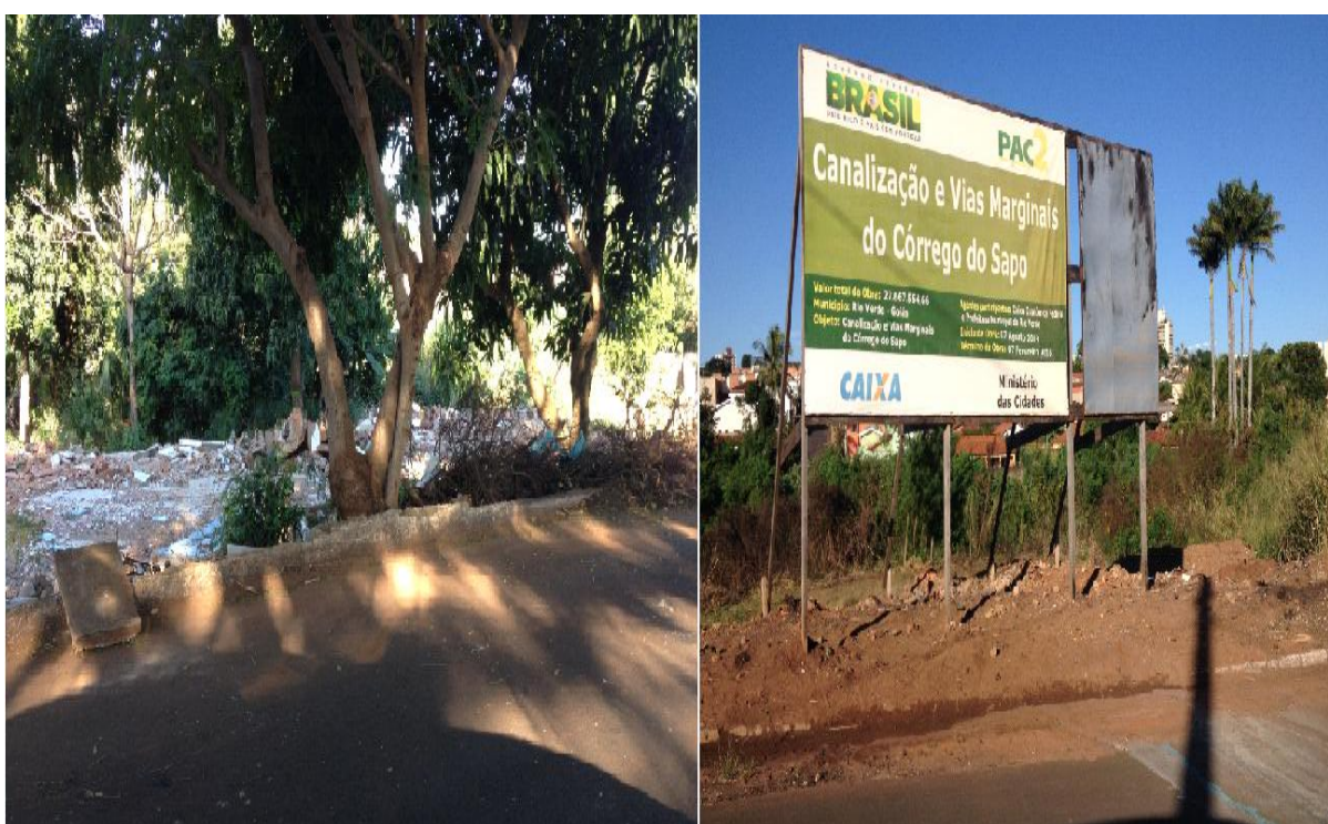
Figura 15 – Segunda fase das obras de canalização do córrego do Sapo
