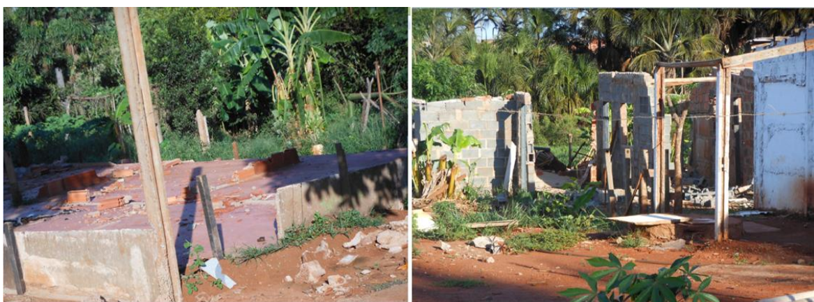
Figura 30 – Destruição das casas edificadas ao longo córrego Veredinha
