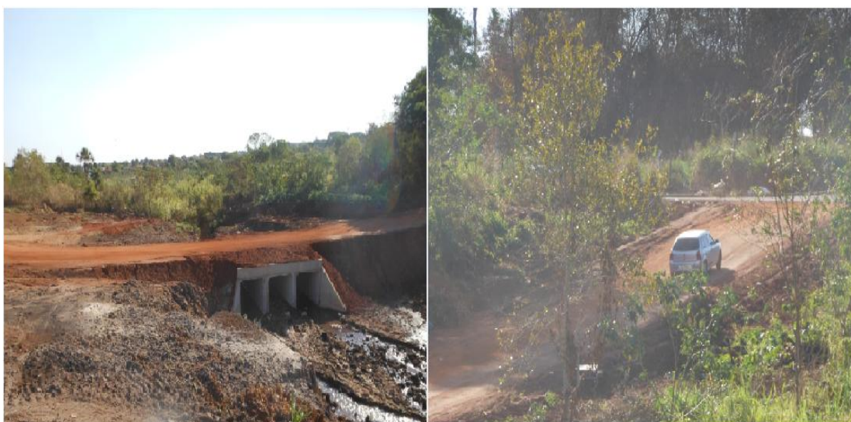
Figura 19 – Travessia construída no córrego Chapadinha em 2015
