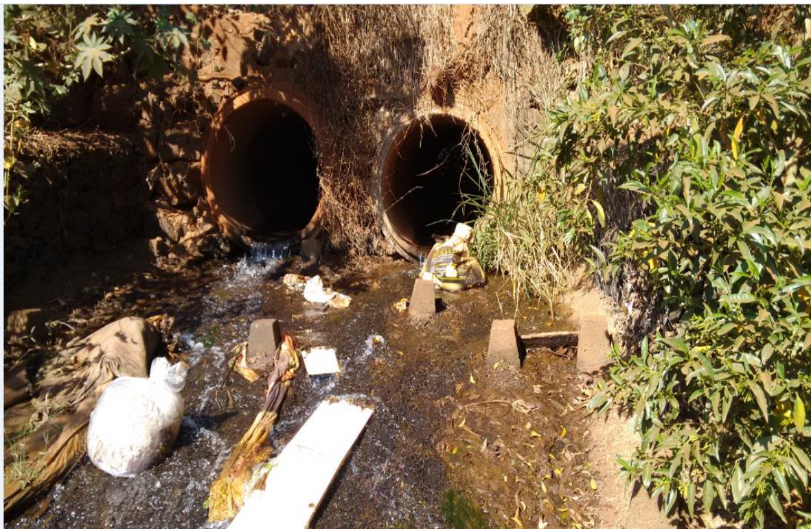
Figura 34 – Aspecto da travessia construída no córrego Veredinha
