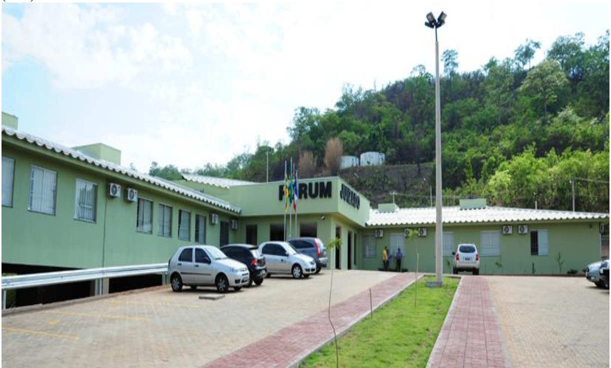
Figura 17 – Fórum da cidade de São Luís de Montes Belos construído em Área de Preservação Permanente (APP)
