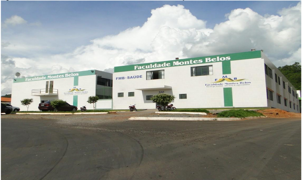
Figura 18 - Faculdade Montes Belos construída em Área de Preservação Permanente (APP)
