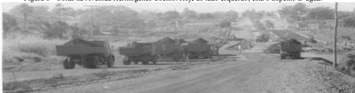
Figura 8 - Obras na Avenida Hermógenes Coelho. Hoje ao lado esquerdo, está o Espelho D'água.
