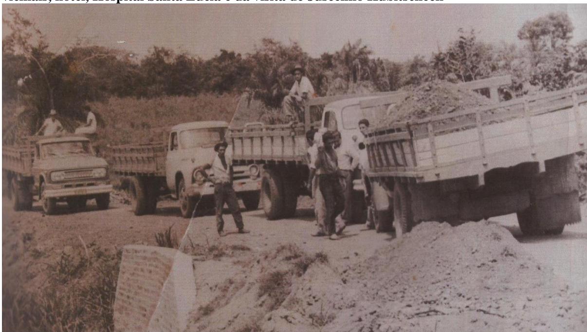
construção das primeiras ruas vicinais da cidade
