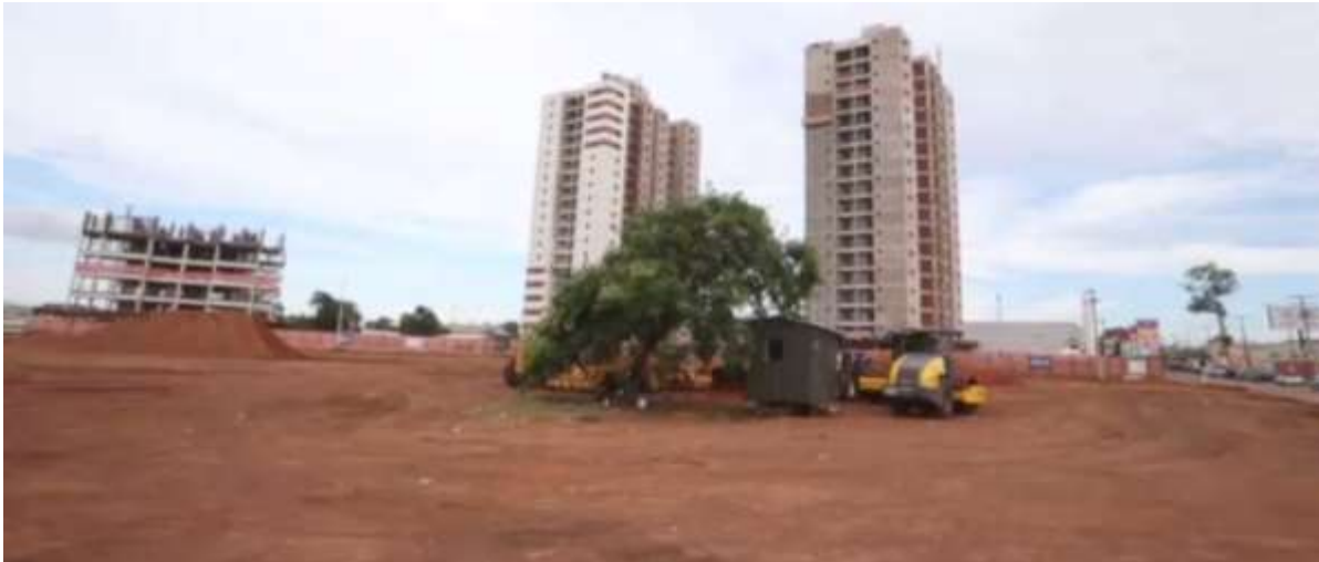
Figura II – Fotografia da área de um dos empreendimentos que serão construídos no lote invadido.
