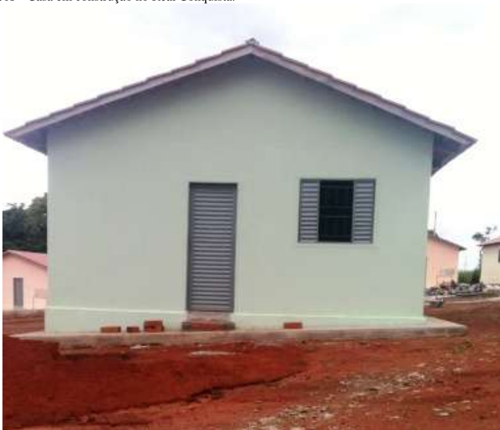
Figura X – Casa em construção no Real Conquista.
