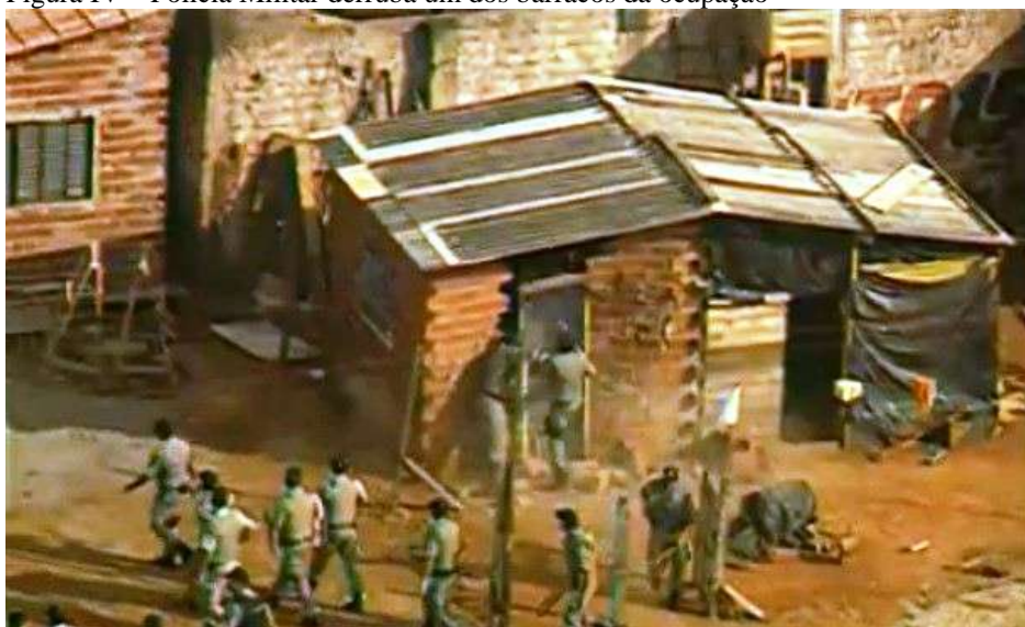
Figura IV – Policia Militar derruba um dos barracos da ocupação
